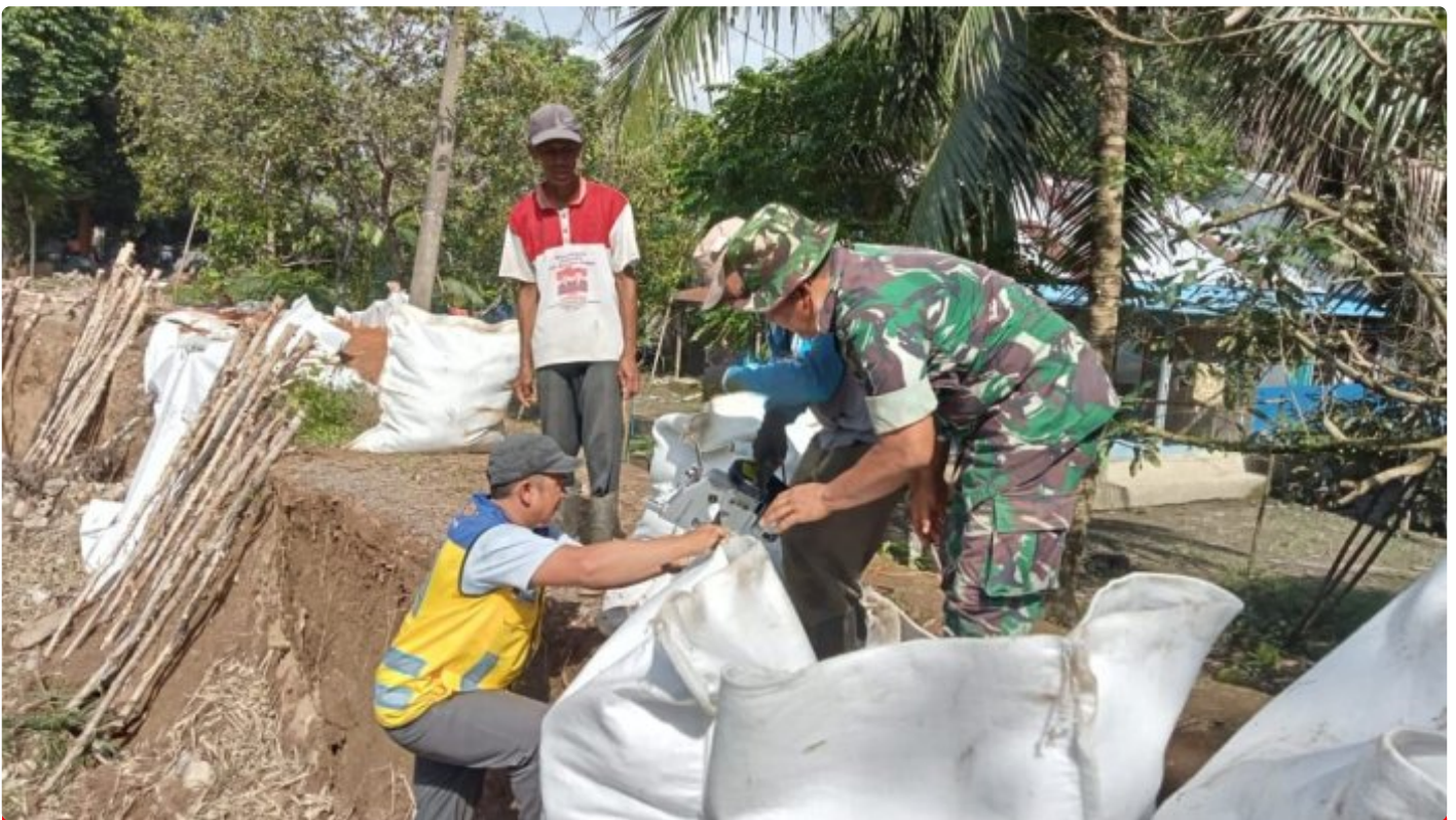
Babinsa Koramil 1002-02/Batang Alai Utara Turun Langsung Gotong Royong Perbaiki Tanggul
